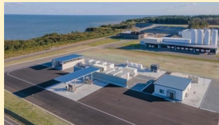
水素ステーション (出展: NEDO)
